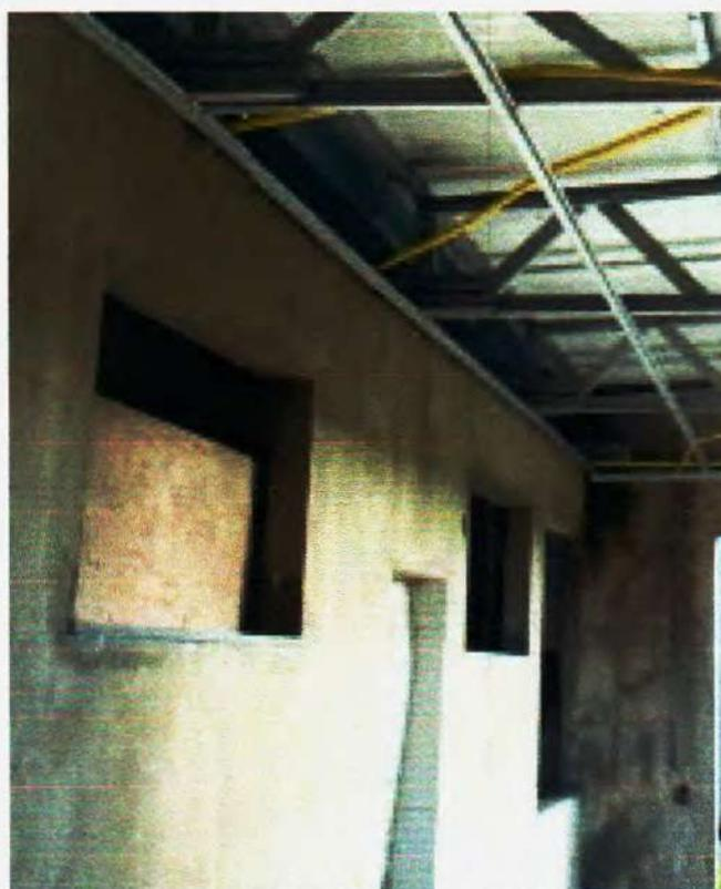
Figura 164 – Peitoril em granito instalado – Fonte:Própria;
