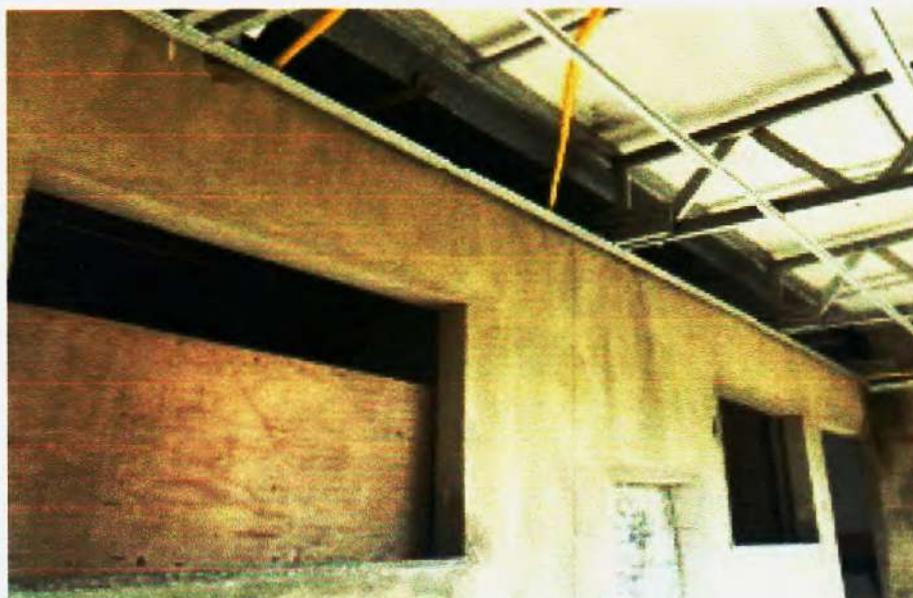
Figura 163 – Peitoril em granito instalado – Fonte:Própria;
