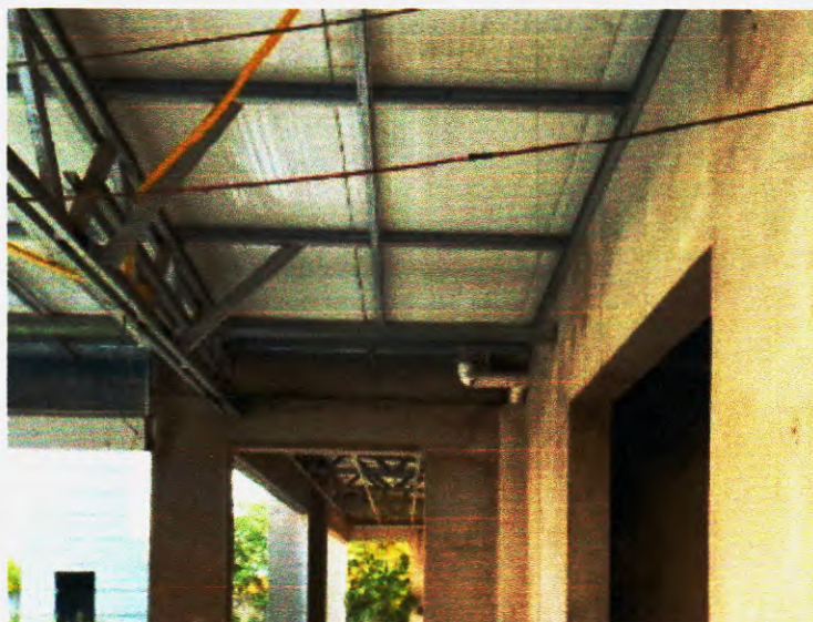
Figura 109 – Tubulação de Drenagem de águas Pluviais – Fonte: Própria;
