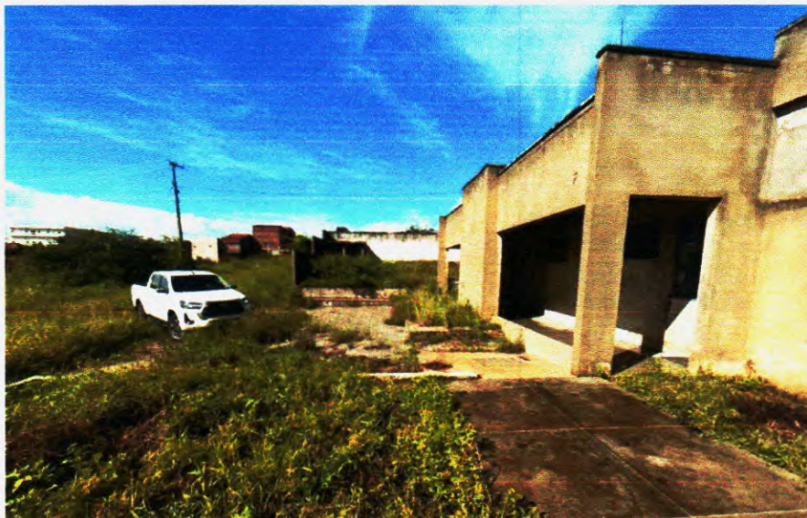
Figura 95 –Pintura Externa a executar – Fonte:Própria;
