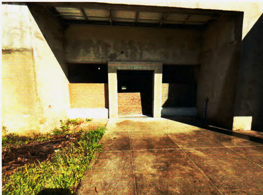
Figura 96 – Pintura Externa a executar – Fonte:Própria;
