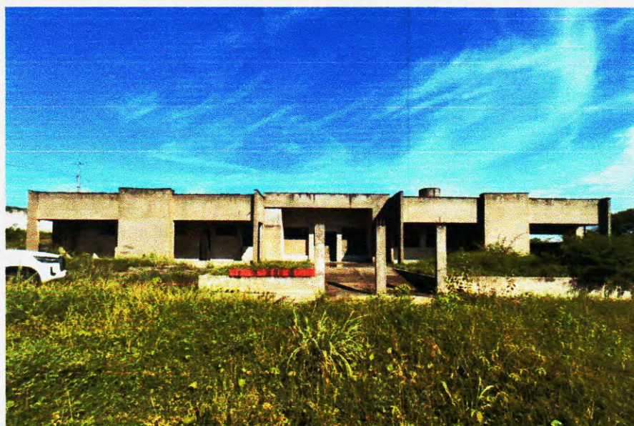
Figura 94 – Pintura Externa a executar– Fonte: Própria;
