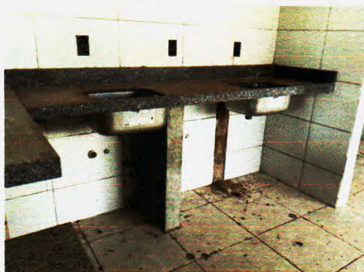
Figura 123 – Falta de Metais – Fonte:Própria;
