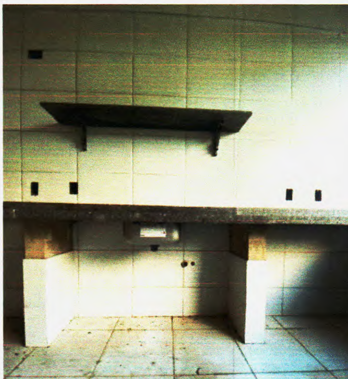
Figura 156 –Bancada de granito executada – Fonte:Própria
