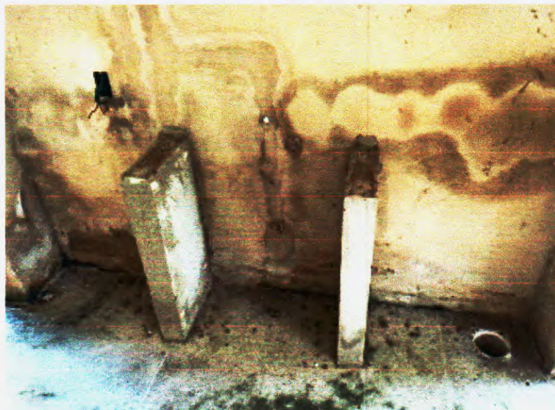
Figura 105 –Pontos hidráulicos executados – Fonte:Própria;
