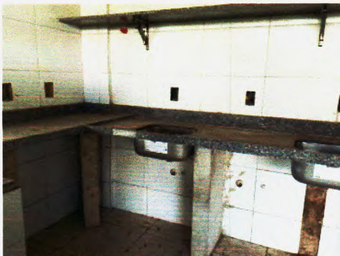
Figura 155 –Bancada de granito executada – Fonte:Própria
