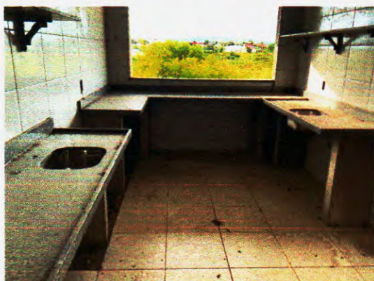
Figura 125 – Falta de Metais – Fonte:Própria;
