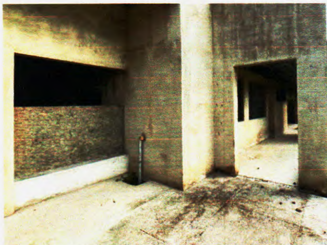
Figura 129 – Ponto Hidrante Externo– Fonte:Própria;
