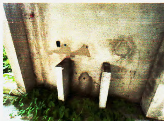
Figura 126 – Falta de Metais – Fonte:Própria;
