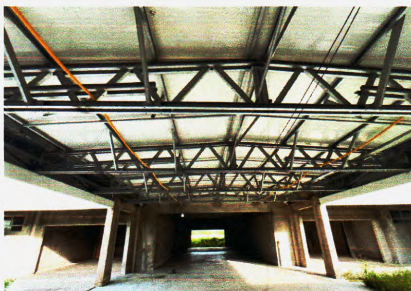
Figura 140 – Instalações elétricas executadas parcialmente – Fonte:Própria;
