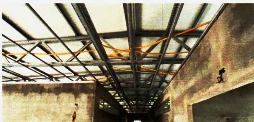
Figura 136 – Instalações elétricas executadas parcialmente – Fonte: Própria;
