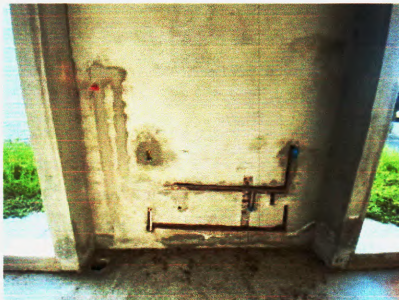
Figura 103 –Pontos hidráulicos executados – Fonte:Própria;
