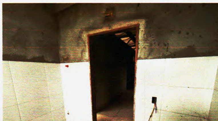
Figura 139 – Instalações elétricas executadas parcialmente – Fonte:Própria;
