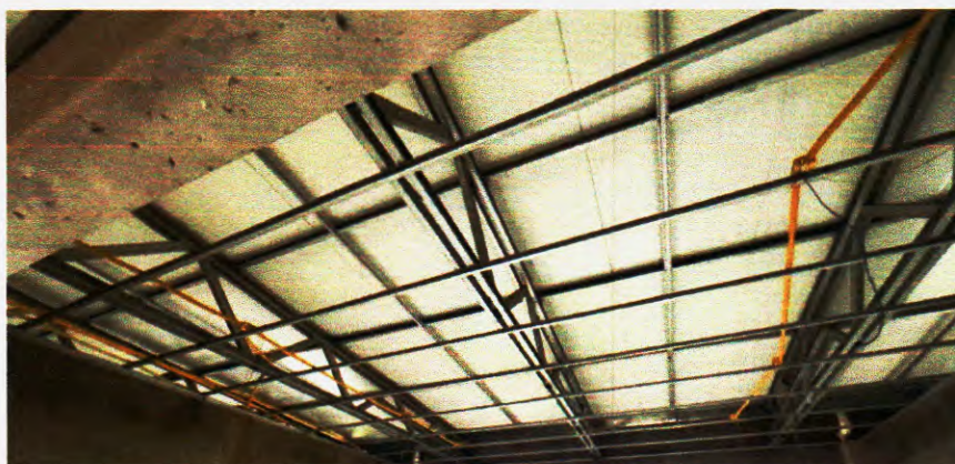
Figura 134 – Instalações elétricas executadas parcialmente – Fonte: Própria;
