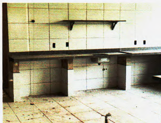
Figura 124 – Falta de Metais – Fonte:Própria;
