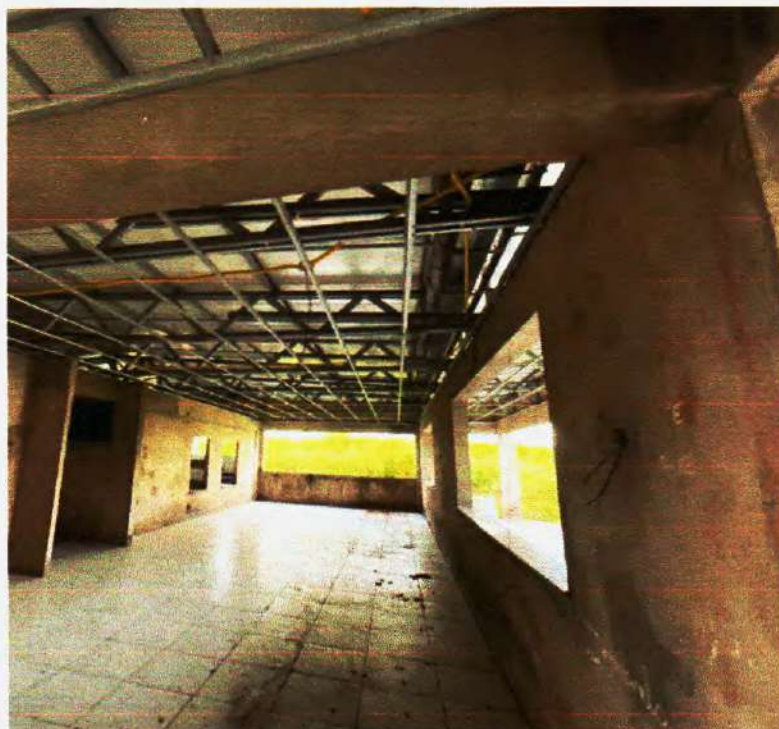
Figura 28 – Alvenarias em boas condições – Fonte: Própria
