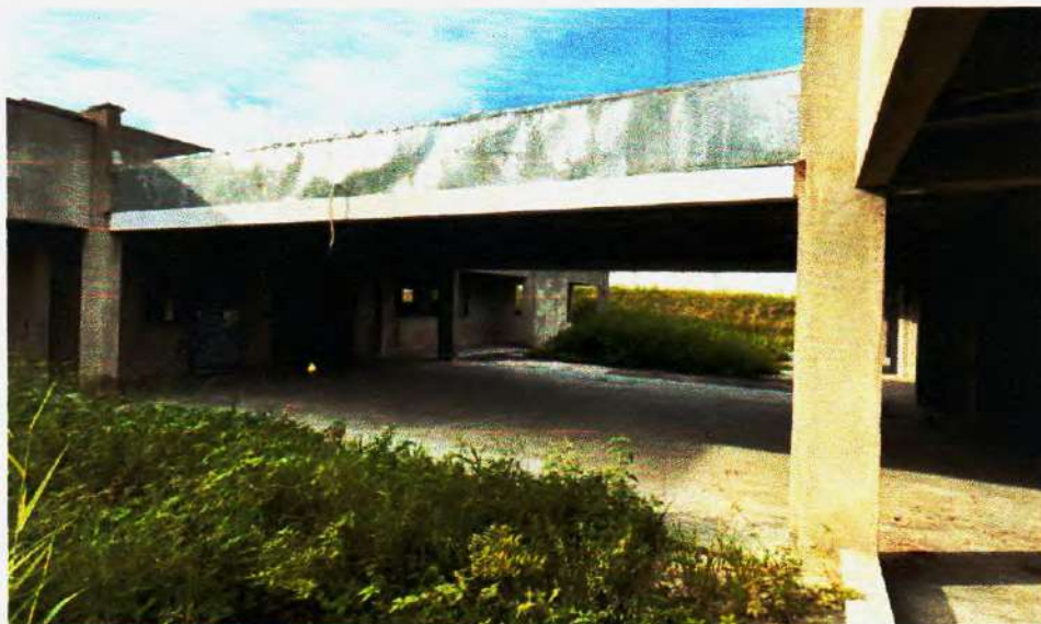
Figura 44 – Ausência de Portas de alumínio de vidro– Fonte:Própria;
