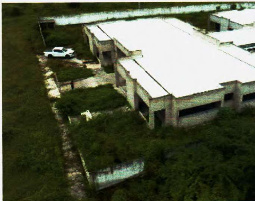
Figura 36 – Construção de Alvenarias Mureta – Fonte: Própria;
