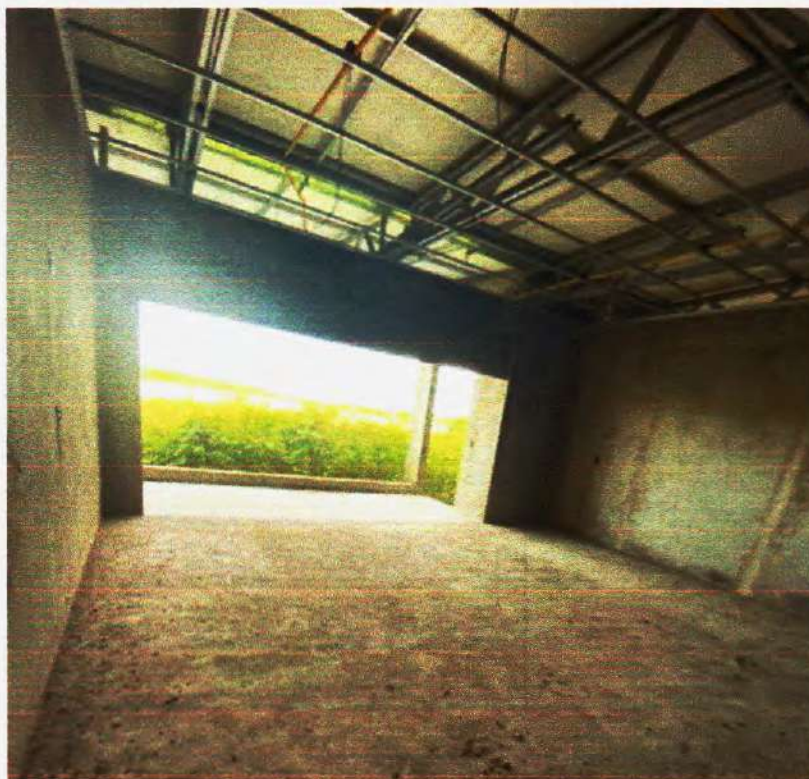
Figura 32 – Alvenarias em boas condições – Fonte: Própria
