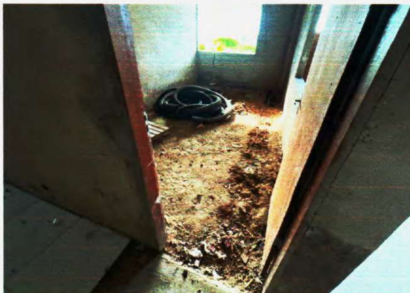
Figura 76 – Acabamentos Revestimento Cerâmico a executar – Fonte: Própria;
