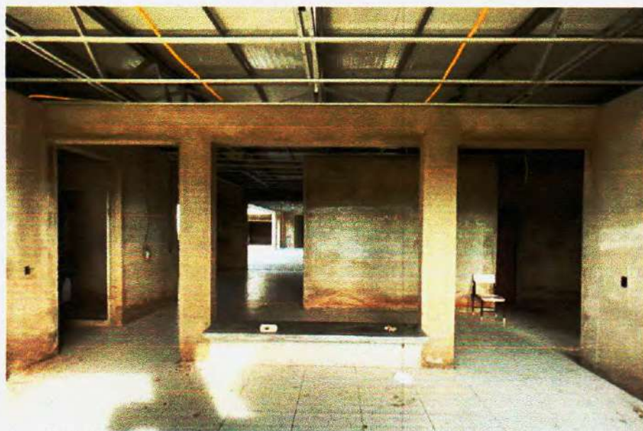
Figura 19 – Pilares, vigas e paredes em bom estado de conservação – Fonte: Própria;
