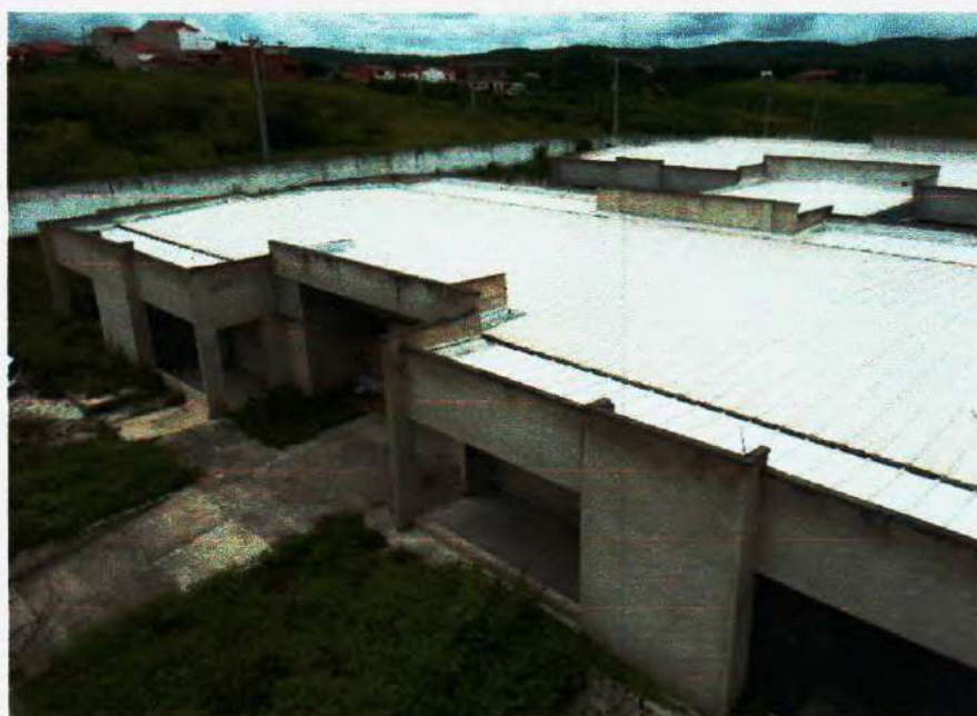
Figura 17 – Vista aérea edificação (estrutura sem deformações) – Fonte:Própria;
