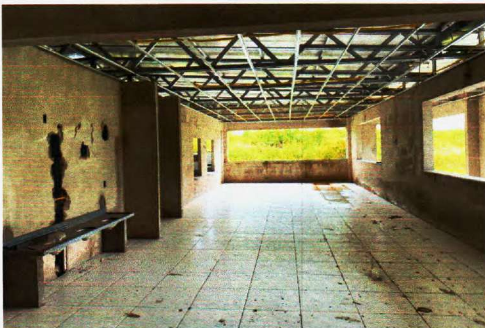
Figura 78 – Revestimento cerâmico de Piso Executado– Fonte: Própria;
