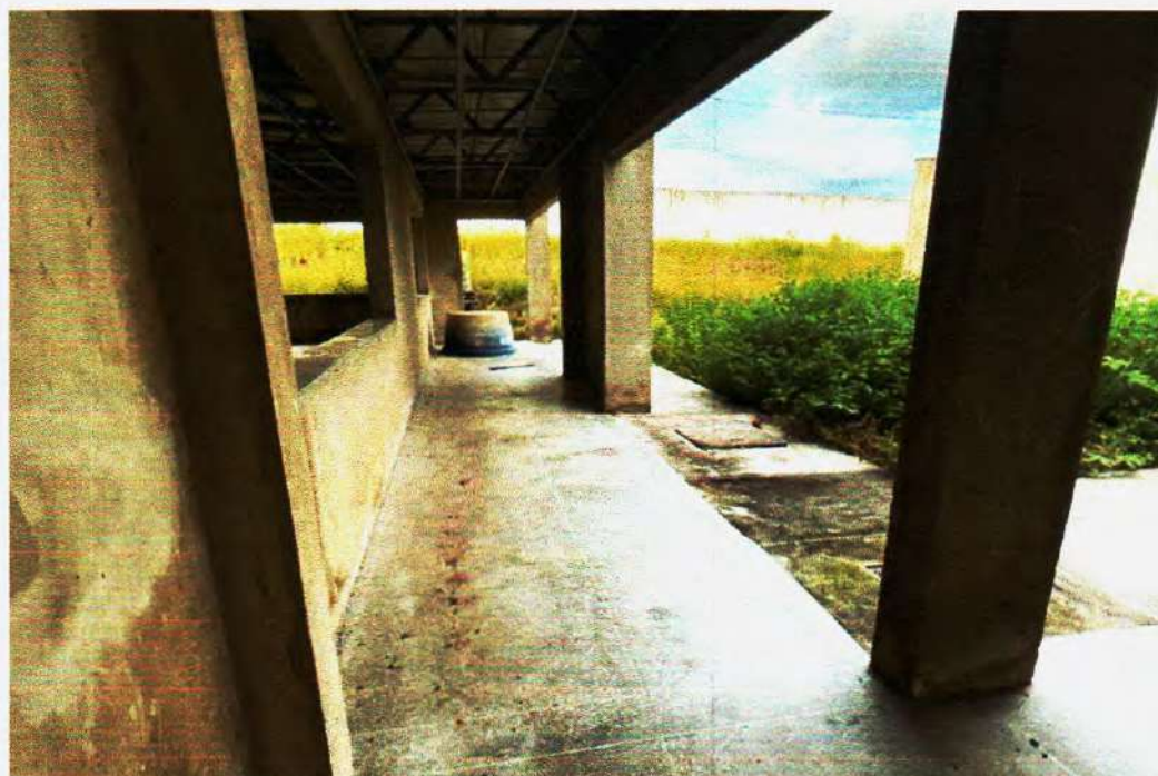
Figura 23 – Pilares, vigas e paredes em bom estado de conservação – Fonte: Própria;
