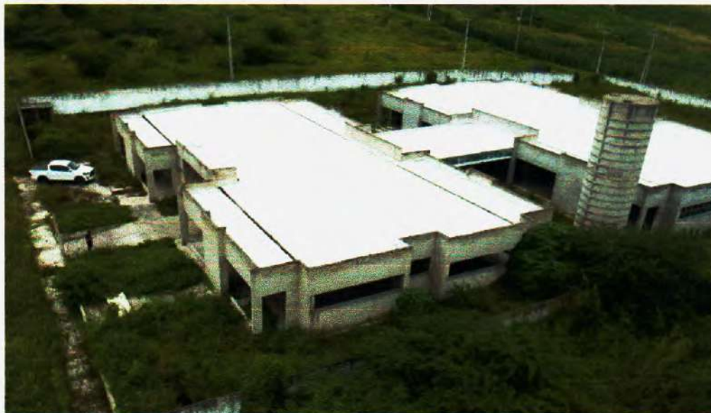
Figura 15 – Vista aérea edificação (estrutura sem deformações) – Fonte: Própria;
