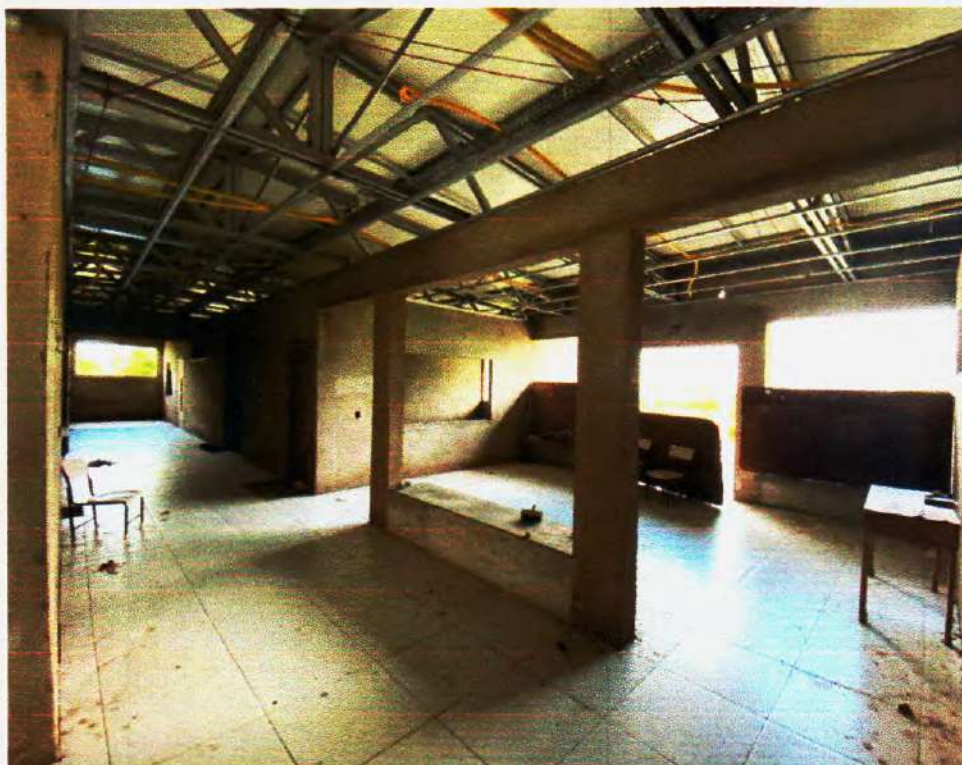
Figura 79 – Revestimento cerâmico de Piso Executado– Fonte: Própria;
