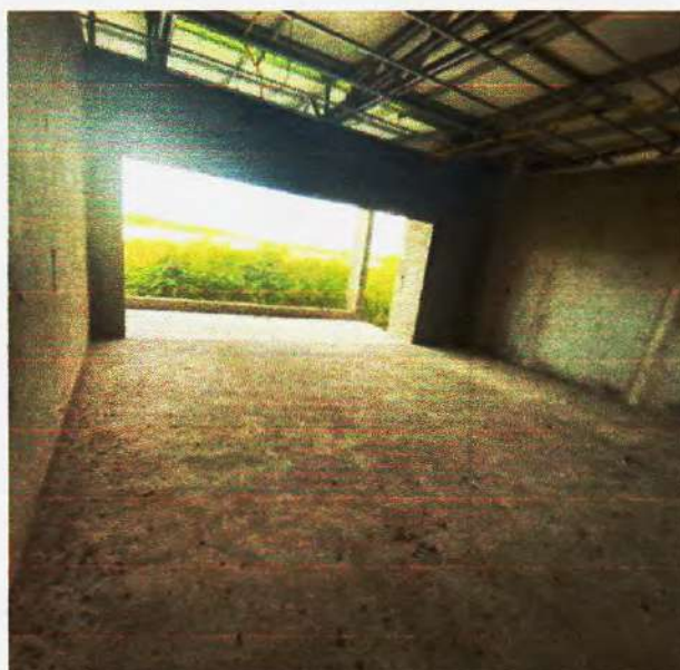
Figura 9 – Pilares, vigas e paredes em bom estado de conservação – Fonte:Própria;
