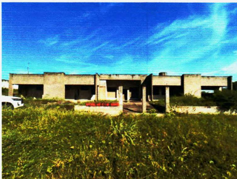
Figura 35 – Construção de Alvenarias Mureta – Fonte: Própria;
