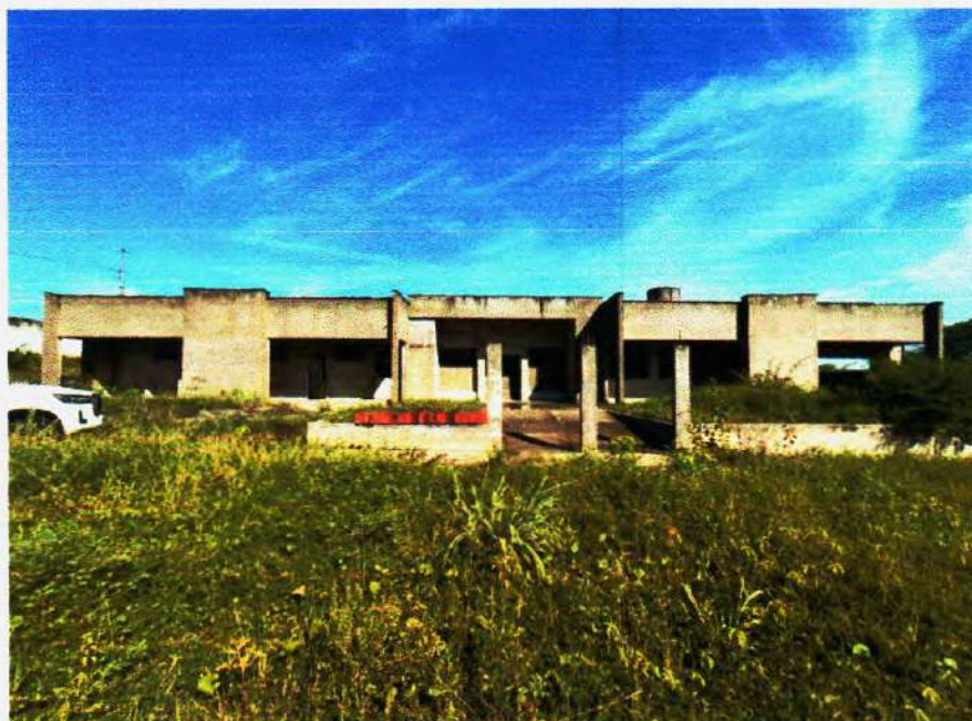
Figura 57 – Fachada da Escola ainda não executada – Fonte:Própria
