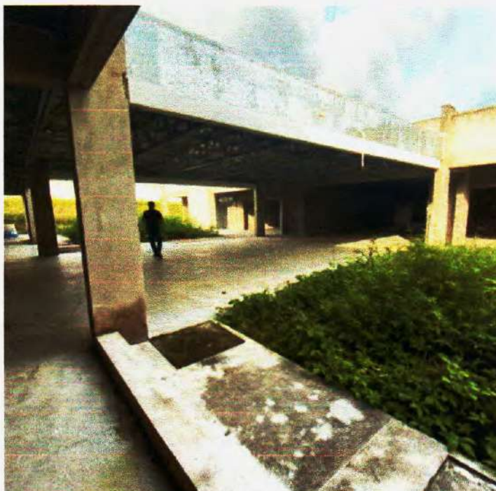
Figura 12 – Pilares, vigas e paredes em bom estado de conservação – Fonte: Própria;
