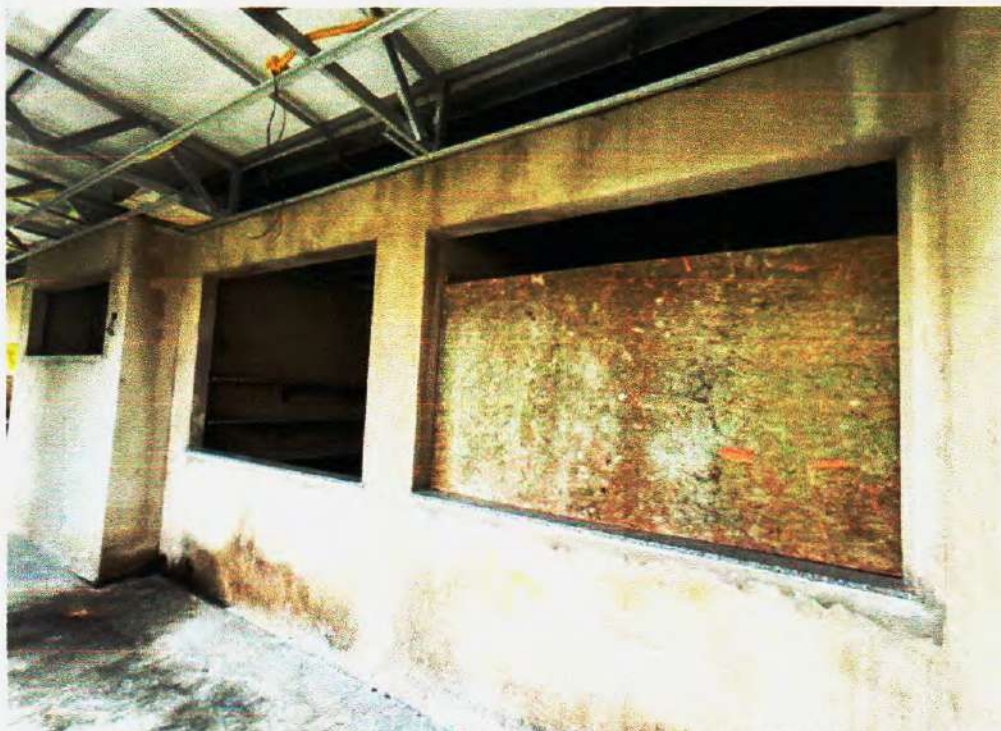
Figura 22 – Pilares, vigas e paredes em bom estado de conservação – Fonte: Própria;
