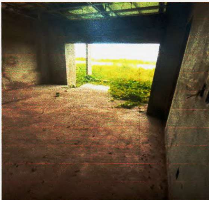
Figura 10 – Pilares, vigas e paredes em bom estado de conservação – Fonte: Própria;
