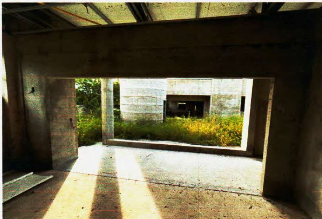
Figura 20 – Pilares, vigas e paredes em bom estado de conservação – Fonte: Própria;
