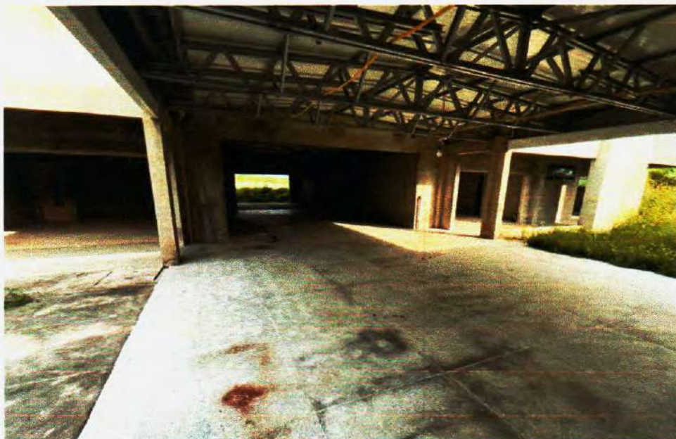
Figura 24 – Pilares, vigas e paredes em bom estado de conservação – Fonte: Própria;
