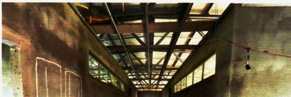
Figura 53 – Janelas Executadas– Fonte:Própria
