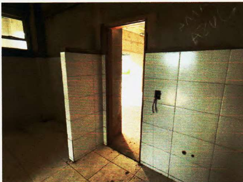
Figura 71 – Revestimento Cerâmico colorido não executado – Fonte:Própria;
