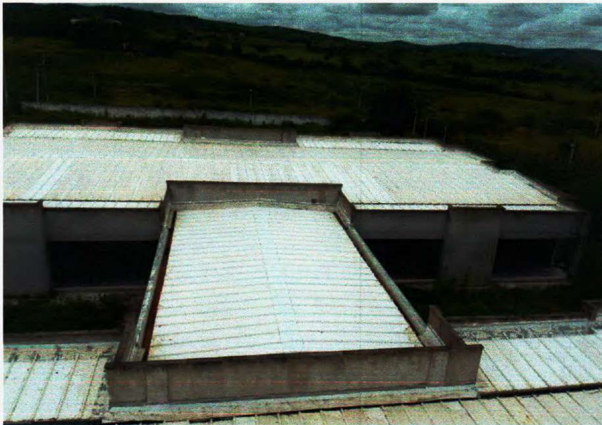
Figura 18 – Vista aérea edificação (estrutura sem deformações) – Fonte: Própria;
