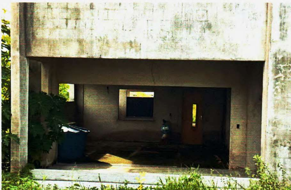
Figura 21 – Pilares, vigas e paredes em bom estado de conservação – Fonte: Própria;
