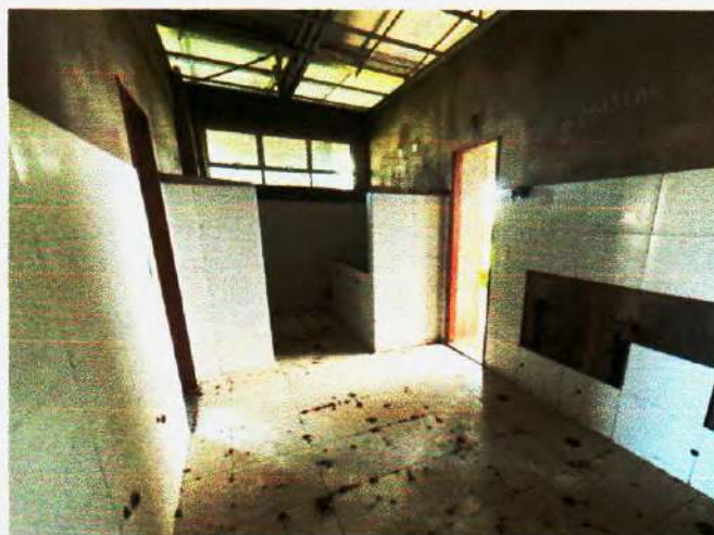
Figura 52 – Janelas Executadas– Fonte:Própria;
