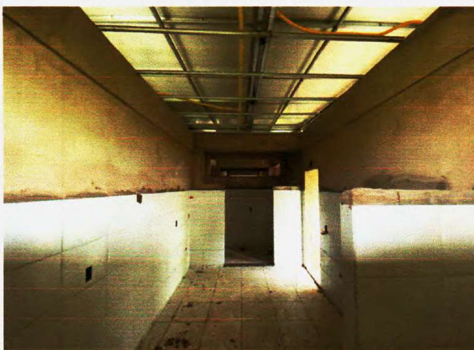
Figura 80 – Revestimento cerâmico de Piso Executado– Fonte: Própria;
