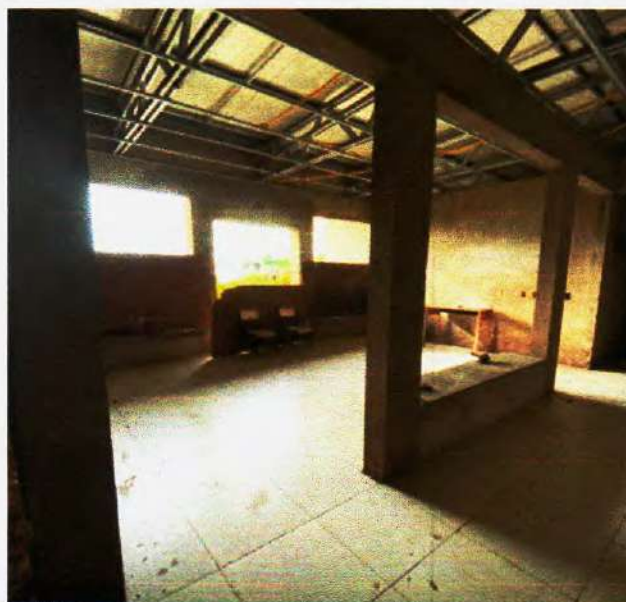
Figura 13 – Pilares, vigas e paredes em bom estado de conservação – Fonte: Própria;
