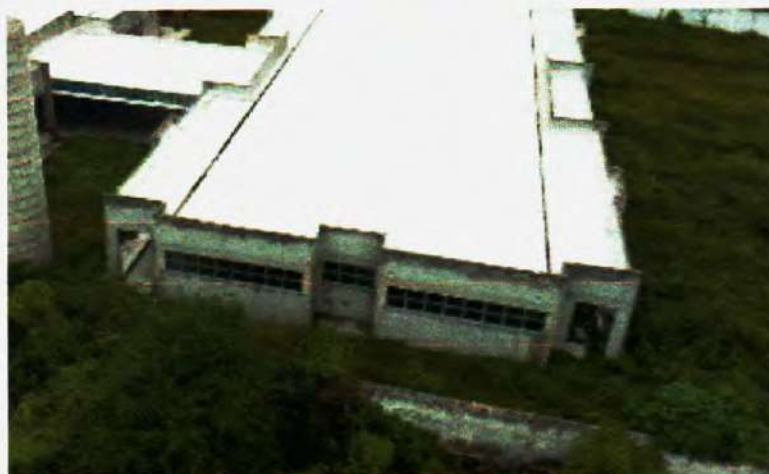
Figura 54 – Janelas Executadas– Fonte:Própria
