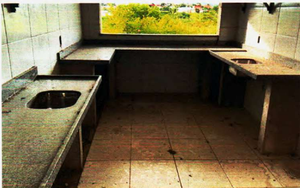
Figura 77 – Acabamentos Revestimento Cerâmico a Executar– Fonte: Própria;
