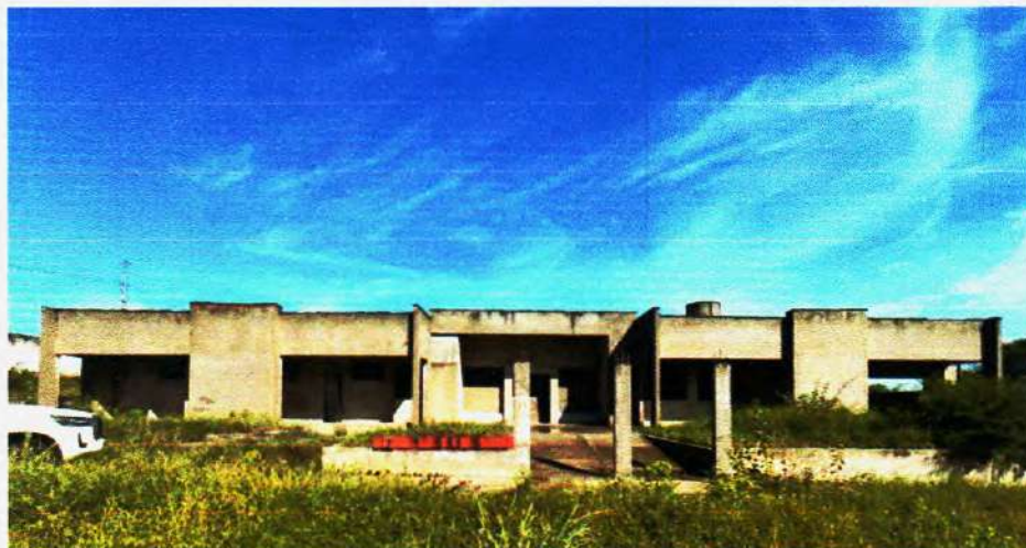
Figura 14 – Pilares, vigas e paredes em bom estado de conservação – Fonte: Própria;
