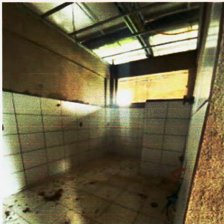
Figura 34 – Alvenarias em boas condições – Fonte: Própria
