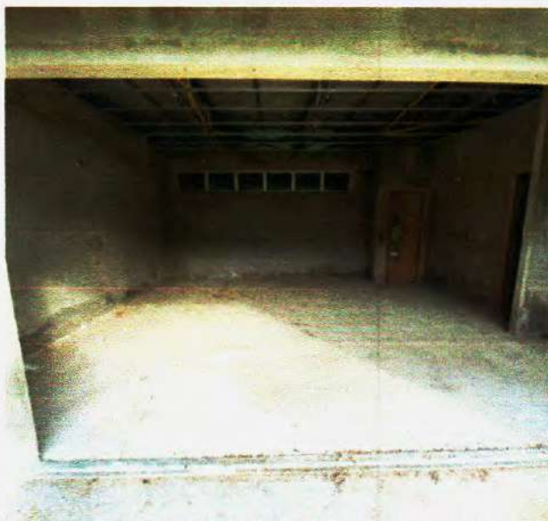
Figura 11 – Pilares, vigas e paredes em bom estado de conservação – Fonte: Própria;
