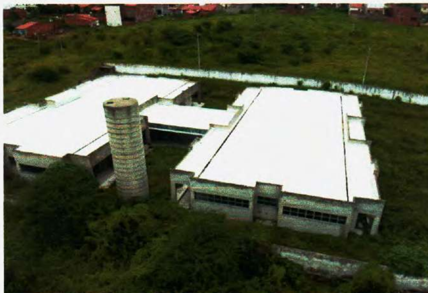
Figura 16 – Vista aérea edificação (estrutura sem deformações) – Fonte:Própria;
