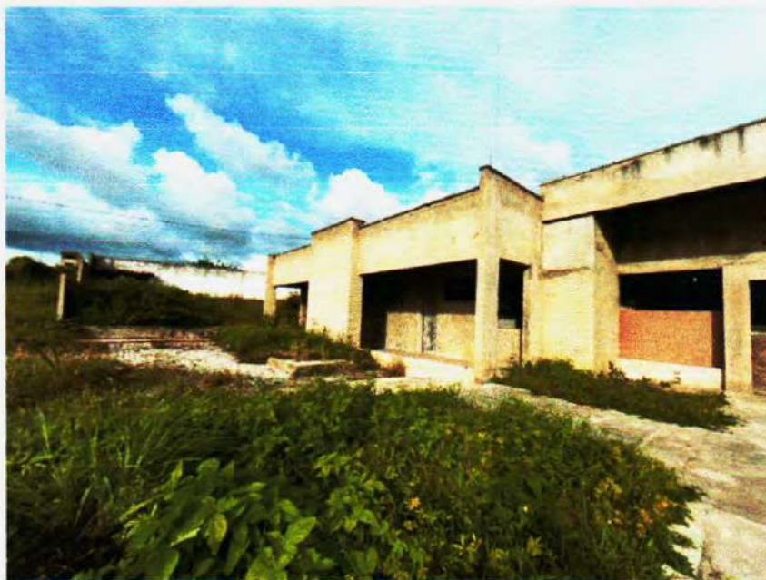
Figura 55 – Varanda de Serviço ainda não executado– Fonte:Própria;
