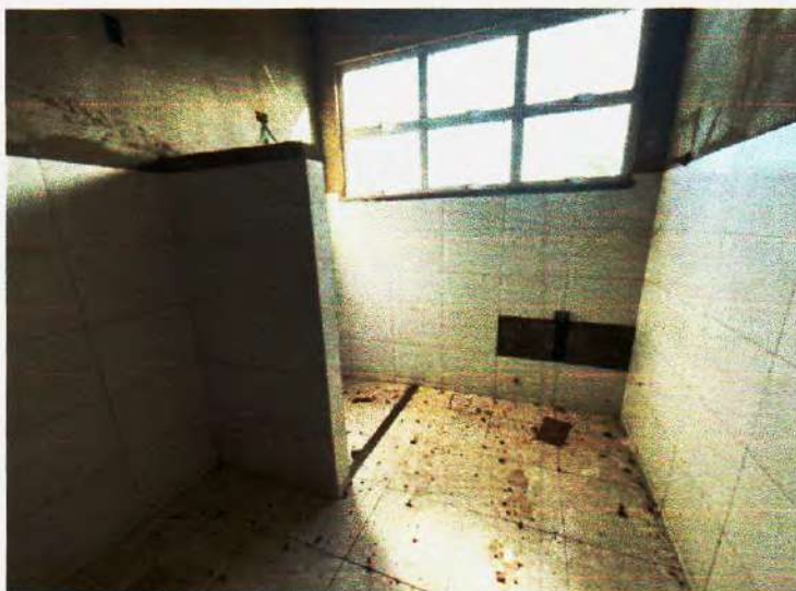
Figura 51 – Janelas Executadas– Fonte:Própria;
