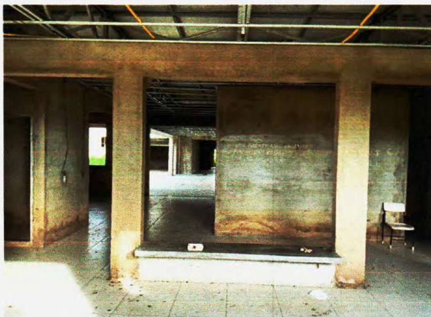
Figura 29 – Alvenarias em boas condições – Fonte: Própria
