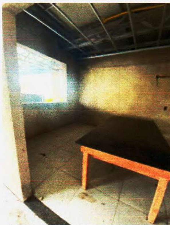
Figura 33 – Alvenarias em boas condições – Fonte: Própria
